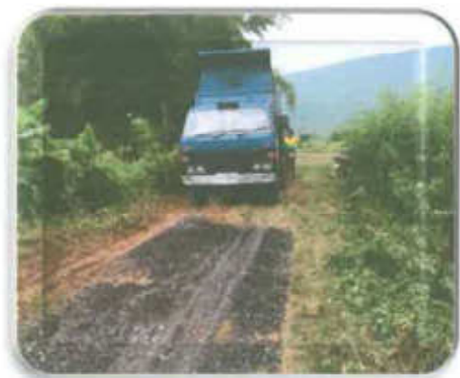
โครงการปรับปรุงถนนโดยการลงหินคลุก
